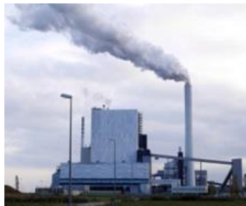
Kohlekraftwerk von Onyx in Wilhelmshaven.
